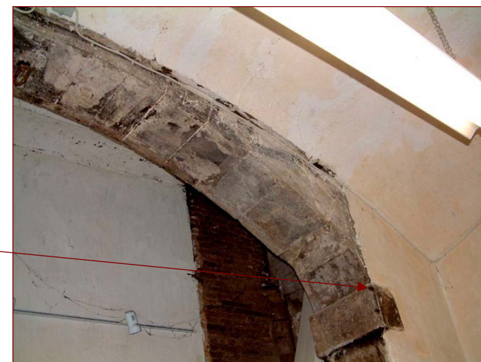
Vista parcial de l'arc que suporta la façana del segle XVII i que actualment es visible des de l'interior de les construccions del costat més septentrional del pati central de la finca
