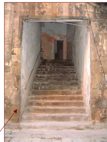
Accés situat en la part més occidental de la façana de l'edifici construït de vell nou en el segle XVII. Es tracta d'un antic accés a la planta baixa adaptat al segle XIX com a escala d'accés a la caixa d'escala de veïns i al ras de principal
