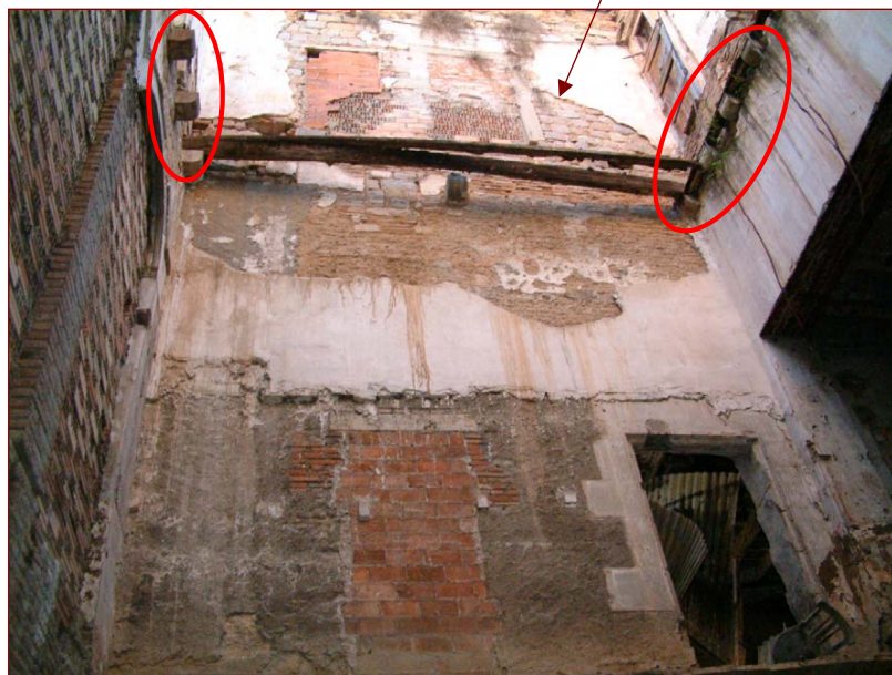
Vista en picat de l'actual pati d'enderroc del costat més oriental de la finca. S'assenyalen els permòdols que sostenien el forjat dels pisos que es construïren en el segle XVII tot aprofitant l'antic pati medieval
