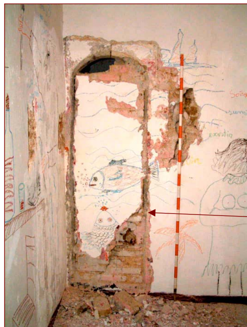
Detall de la cara interior de la porta descoberta a l'estança nord-oest del primer pis. Es tracta probablement d'un pas que comunicava amb un antiga escala de cargol, que, en volada sobre la façana medieval, comunicava els pis amb la coberta. És un element datable cap inici del segle XVI
