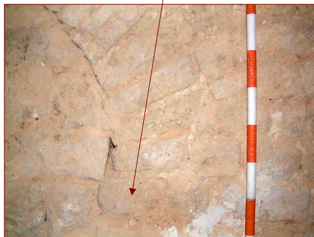
Vista general i detall de la cara interna de la porta descoberta en el corresponent al segon pis de la torre romana núm. 28. Es fa difícil esbrinar quina ha estat la raó per la qual en comptes d'una finestra (que seria el més lògic) ens trobem amb un porta. Probablement som davant d'una reforma o bé existia d'origen una comunicació a l'alçada del segon pis entre les torres 27 i 28
