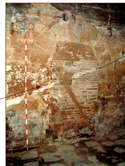
Detall de la porta adovellada que es localitza a la paret nord de l'actual vestibul de la finca. És, junt la seva paret, resultat de les obres del segle XVI que construïren un nivell d'entresòl (estudi) dins la crugia medieval de l'edifici
