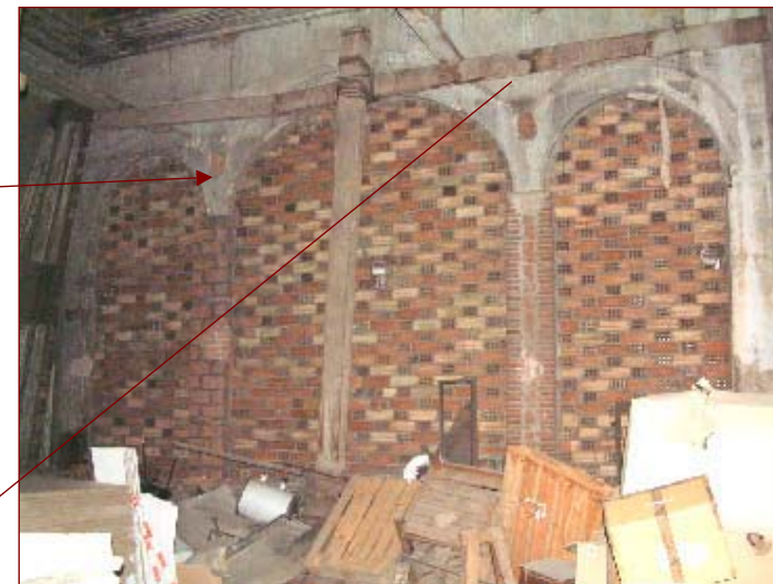
Detall de la cara interna de la galeria cegada del primer pis de l'edifici del costat nord-est de la finca. Cap a la fi del segle XIX. S'assenyala el pilar que fou repicat i que mostrà la columna de ferro colat
