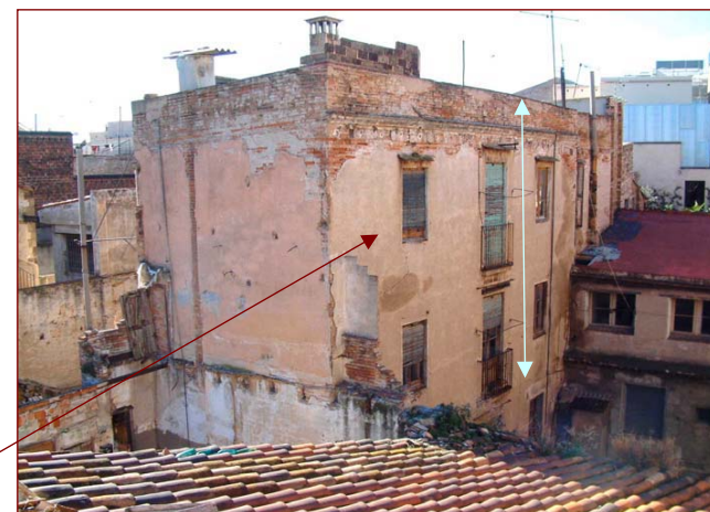
Vista de la remunta realitzada a mitjan del s. XIX de l'edifici més meridional de la finca. Les obres comportaren a més la construcció de l'actual l'escala de veïns i la reordenació de les circulacions interiors de la finca
