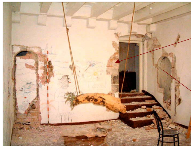
Vista general de l'estança nord-est del primer pis de l'edifici que dona al carrer Lledó. A banda de les dues portes descobertes (vegeu imatges inferiors) també podem distingir l'arc rebaixat i un muntant (l'esquerra) del que interpretem com la cara interna d'una antiga obertura de finestra de la façana medieval
