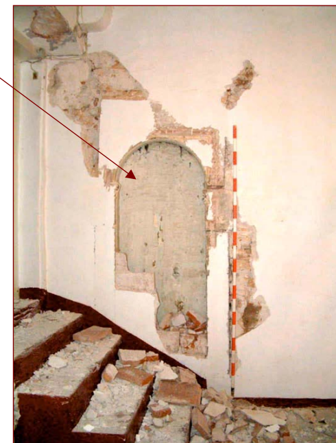
Detall de la porta descoberta en la paret lateral de l'estança nord-oest del primer pis. Som davant d'un pas noble entre dues habitacions que en base a la seva fesomia s'identificaria com un element pertanyent a la primera meitat del segle XVI
