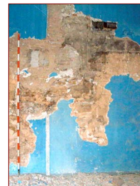
Imatge on es pot identificar part de la llinda lobular d'una finestra coronella que s'obria a l'antiga façana i que configurava junt amb la llotja l'acabat del darrer nivell del frontis interior del segle XIV.
