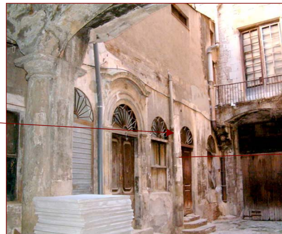
Localització i detall del pilar que sostenia una naia o corredor que comunicava les zones oest i est de la finca en el segle XVII
