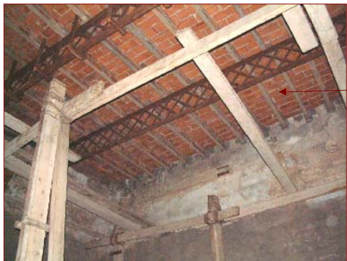
Vista parcial de l'actual forjat de jàsseres de gelosia i biguetes de formigó del primer pis de l'edifici del costat nord-est de la finca. Es tracta d'una operació de reforma en dues fases. Les jàsseres es correspondrien a una operació de final del segle XIX, mentre que les biguetes de formigó pertanyent ja al segle XX
