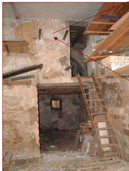
Localització i detall de la cara externa de la finestra del primer pis de la torre 28 que donava a l'interior de la ciutat
