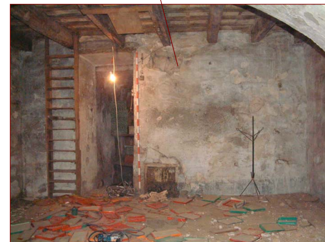
Localització i detall de la cara interna de la finestra del primer pis de la torre romana núm. 28 que s'obria a l'interior de la ciutat
