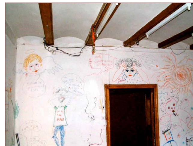
Detall del forjat de bigueta de fusta i revoltó resultat de les obres de canvi de soleres de la crugia més oriental del cos construït de façana. Vers mitjan segle XIX
