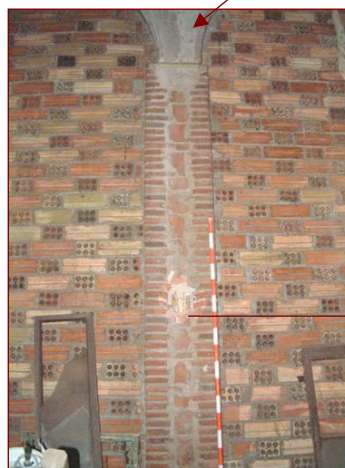
Vista parcial i detall del pilar de maó que enconfra la columna de ferro colat sobre la que se sostenien els arcs de la galeria que dona a l'actual pati d'enderroc
