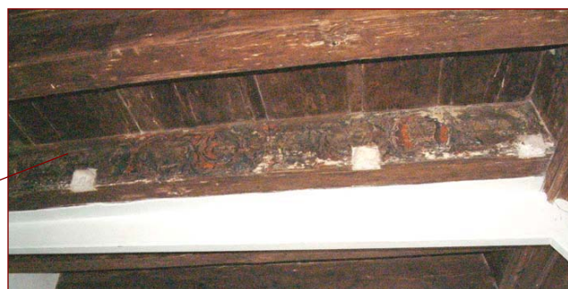
Vista general de la jässera decorada del forjat de fusta del nivell d'entresòl i que correspondria a una reforma del segle XVI que afectà només un part de la planta baixa de l'edifici medieval
