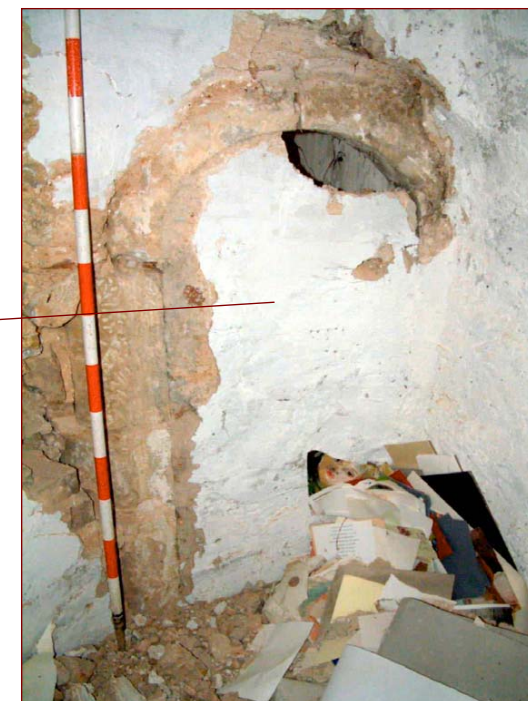
Detall de la cara externa de la porta del segle XVI que de manera versemblant comunicava amb una escala de cargol en volada que comunica els nivells residencials amb el ras de sota coberta
