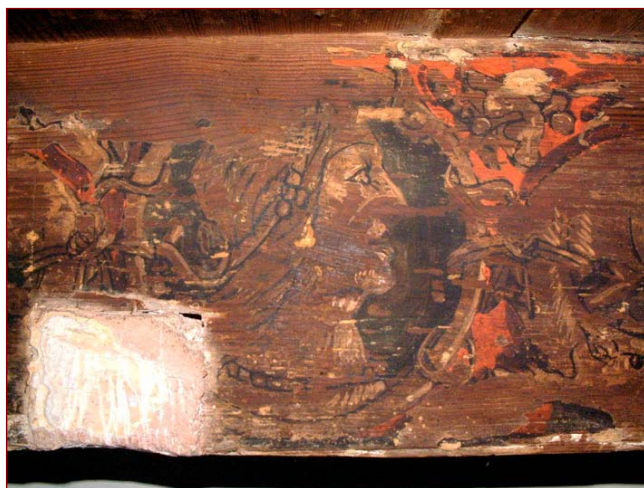
Detall de la decoració pictòrica d'una dels jàsseres de fusta del forjat de l'entresòl o estudi. Podem distingir el perfil d'una dama representada segons els paràmetres propis de les imatges figuratives del segle XVI
