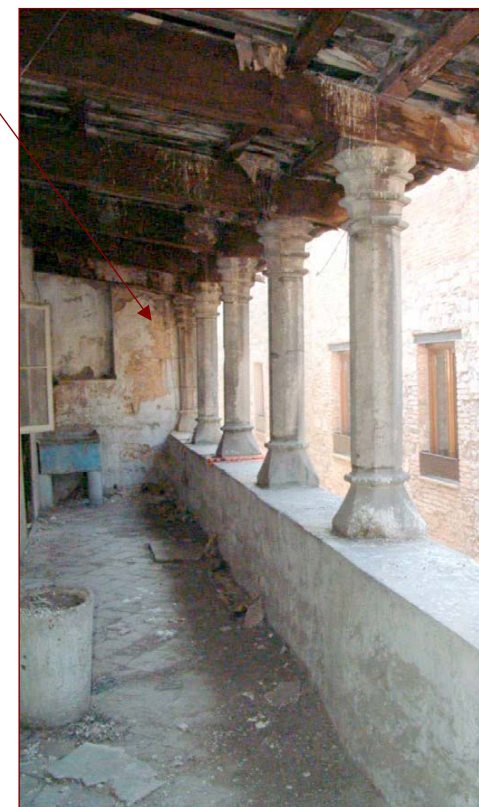
Vista general de l'estat actual de la solana del segle XIV. Podem distingir la filera de columnes amb els seus capitells i bases, així com les jàsseres de fusta de la coberta de vessant d'aquesta costat de l'edifici. Altra característica a remarcar seria el seu bon estat de conservació ja que pràcticament no presenta cap restauració ni moderna ni contemporània. Es tractaria, doncs d'una de les solanes medievals millor conservades de Barcelona
