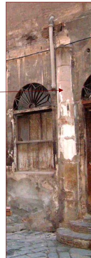
Localització i detall del pilar que sostenia una naia o corredor que comunicava les zones oest i est de la finca en el segle XVII
