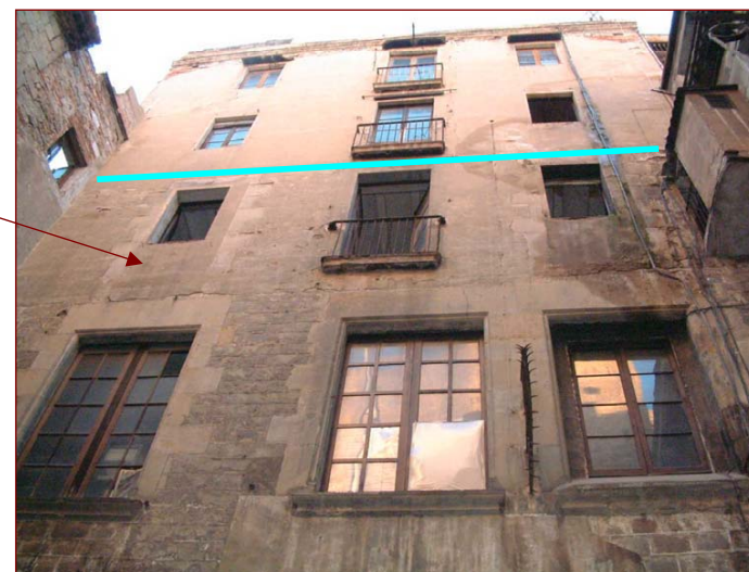
Vista parcial de la façana de l'edifici aixecat de vell nou al segle XVII amb la remunta dels dos pisos superiors feta en el segle XIX
