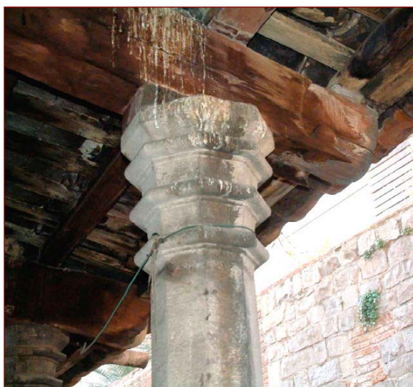
Detall de la part superior i del capitell d'una de les columnes de la solana de l'edifici. Podem distingir la seva fesomia octogonal i la peculiar configuració del capitell, amb un seguit de collarins que circumdem la seva evolució vertical troco-cònic invertida.
