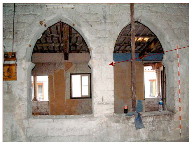
Detall de la cara oriental de l'antic mur de la façana medieval amb la llotja d'arcs apuntats que s'obria a vell pati de la finca
